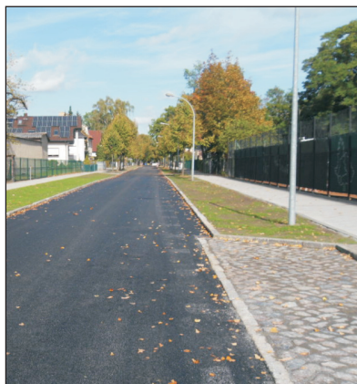
ZUSTAND NACH DEM UMBAU
