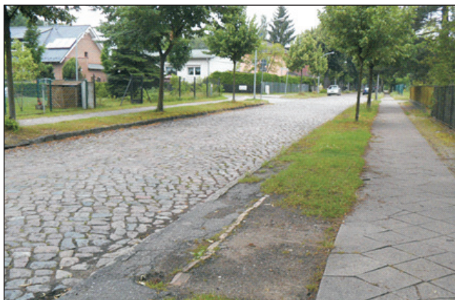
BESTANDSSITUATION HEIDELBERGER STRASSE VOR DEM UMBAU
